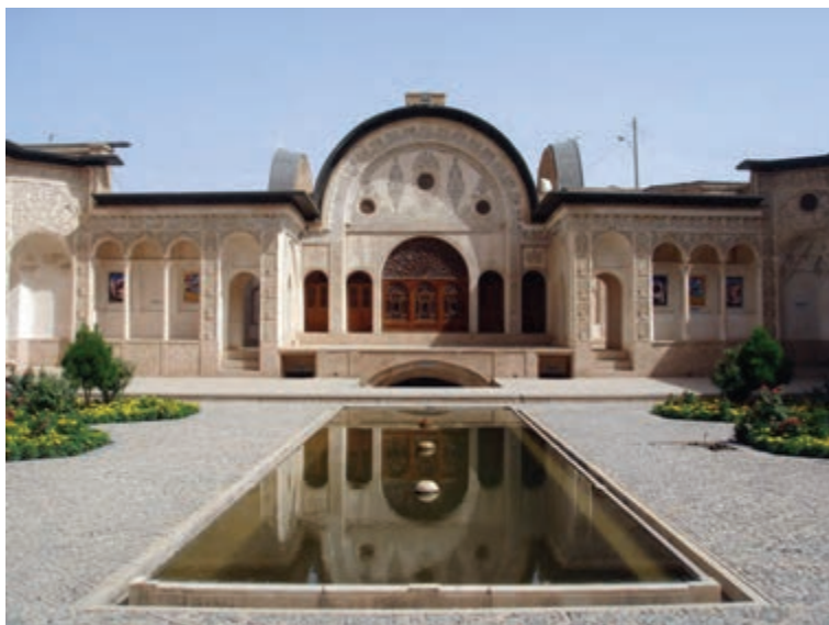
شکل ۲۶-۴ خانه طباطبایی‌ها در کاشان (قوس نیم دایره)
