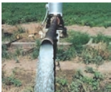
▲ شکل ۹-۲ انتقال آب از طریق لوله
