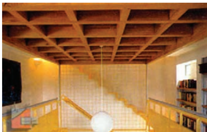
◀ شکل ۱-۵۹- سقف کاذب مشبک چوبی
