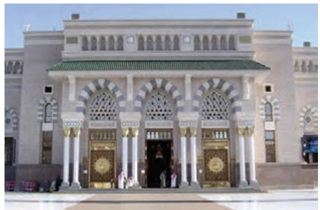
▲ شکل ۴-۷۰ قوس های سنگی (مسجد پیامبر)
