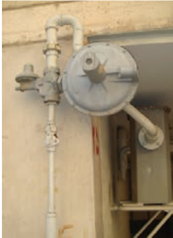
▲ شکل ۲-۹۳ علمک و رگولاتور روی آن
