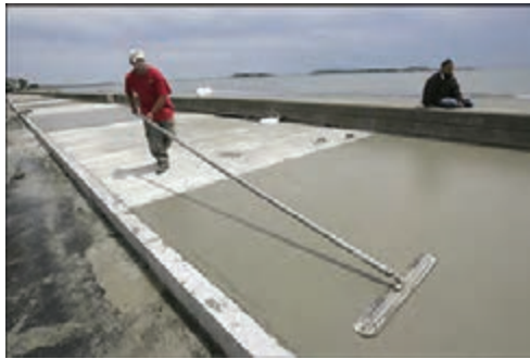
▲ شکل ۳-۵۵ رویه نهایی معابر با بتن درجا
