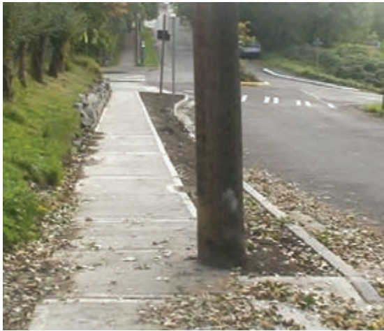
▲ شکل ۳-۴۰ به کارگیری قطعات مجزا در کف‌سازی
