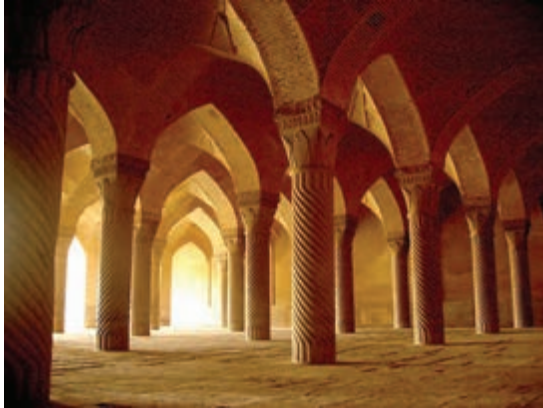
▲ شکل ۴-۶۹ قوس های آجری (مسجد وکیل شیراز)
